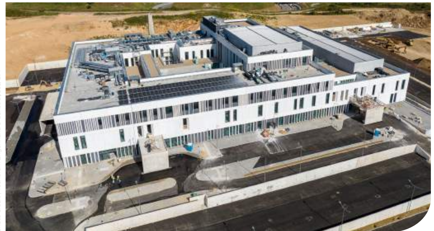
photo credit | Tecnorem Engenharia e Construções, S.A
